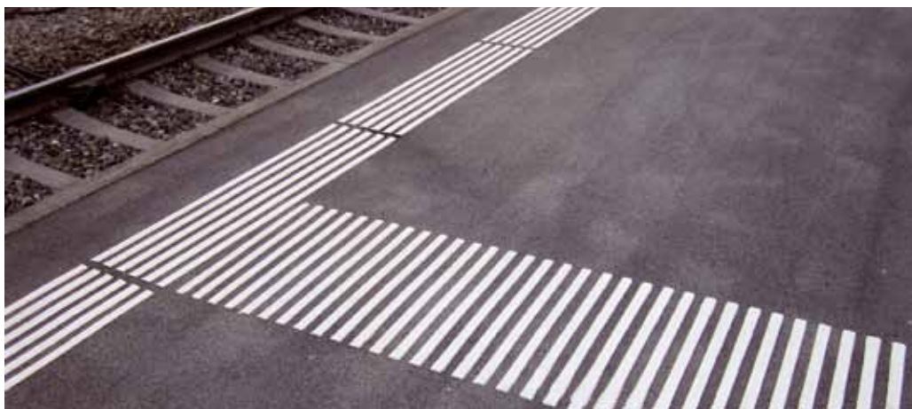
Taktiler Leitliniensystem beim Bahnhof Baar.
