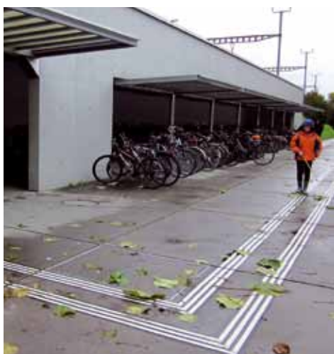
Blindenleitlinien beim Bahnhof in Baar
